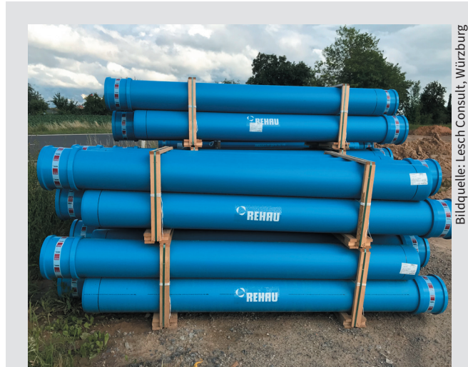
Bild 2: Kunststoffrohrsystem aus Polypropylen PP-HM
