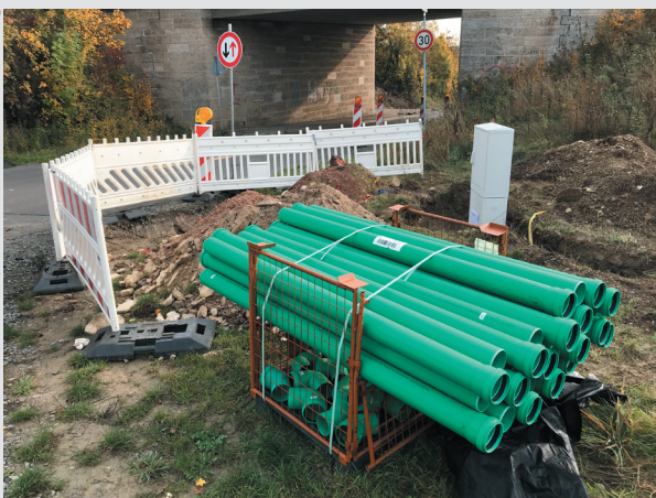
Bild 1: Kunststoffrohrsystem aus Polypropylen PP-MD (KG 2000)
