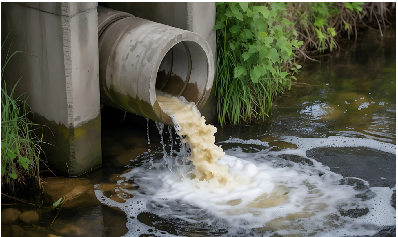
Bild 1: Abwasserentsorgung ohne funktionierende Reinigung durch Kleinkläranlage
